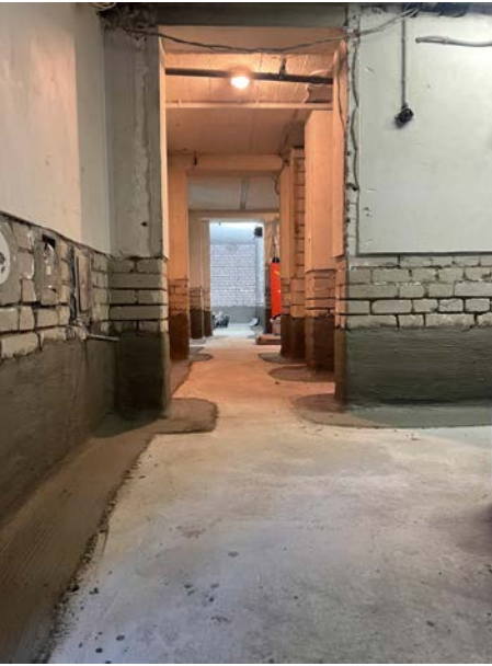
Teilflächige Innen-Boden-Wand-Abdichtung
